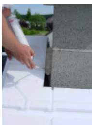
Wärmebrückenfreies Anschäumen an Dachdurchdringung
