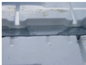
Einlegen des Wasserführungswinkels oberhalb der Durchdringung
